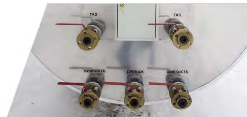
Кран шаровой предназначен для использования в качестве запорного устройства в трубопроводах с жидкими или газообразными рабочими средами.
