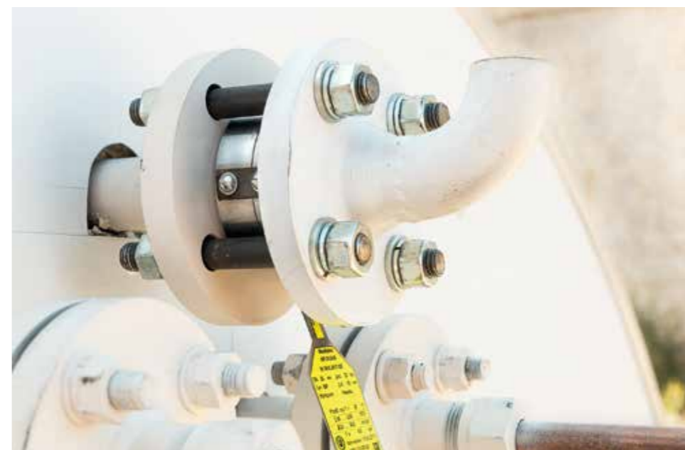
Блок предохранительной мембраны
